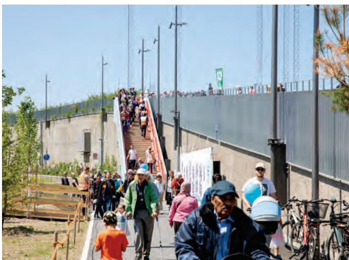
Der Zugang von der Einhausung zum Festgelände wurde als mögliches Nadelöhr identifiziert.
